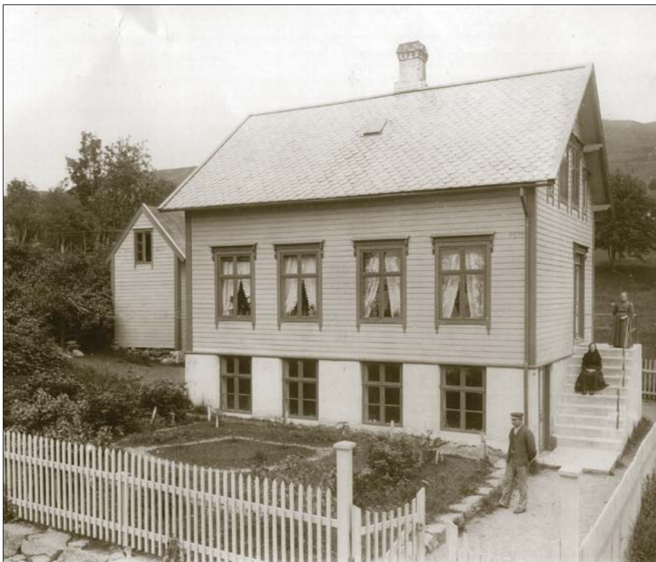
Gnr. 8, bnr. 48 - Fløhuset, eller Krukkehuset som det heiter i dag, er ein representant for det enkle «Ulsteinvikhuset». Det vart bygt både større og mindre bus av denne typen. Loftsrom var ofte utleigd til teneste- eller arbeidsfolk. Dette huset hadde rosemåla detaljar innvendig. Foto ca 1910.
