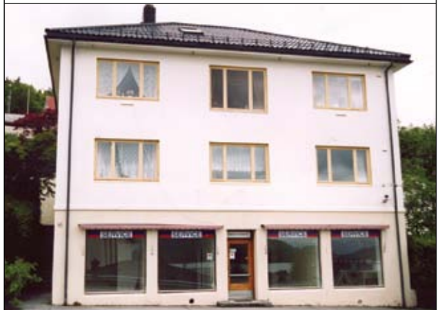
Kyrkjegata (7/149). Byggherre Jan Remo. Dome på enkel funkis i mur. Murverket gjorde at vindauga vanskeleg kunne stå heilt ute mot hjørnet som på «ekte» funkis.
