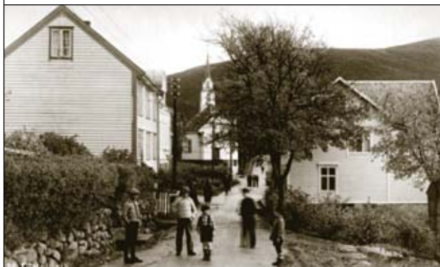
Foto frå Kyrkjegata, truleg frå 1931. Huset til høgre er Norrøna pensjonat, Vågehuset til venstre. Vågeelva brusa friskt langs husveggene når haustregnet kom inn i trusketida.
