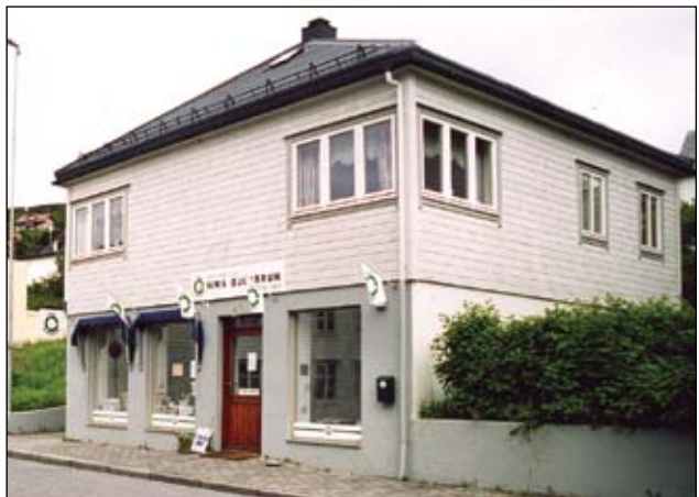
«Ekte» funkis i Kyrkjegata (7/72). Byggherre Jon P. Hasund. Trekonstruksjonen gjorde det enkelt å sette vindauga heilt ut mot hjørnet.
