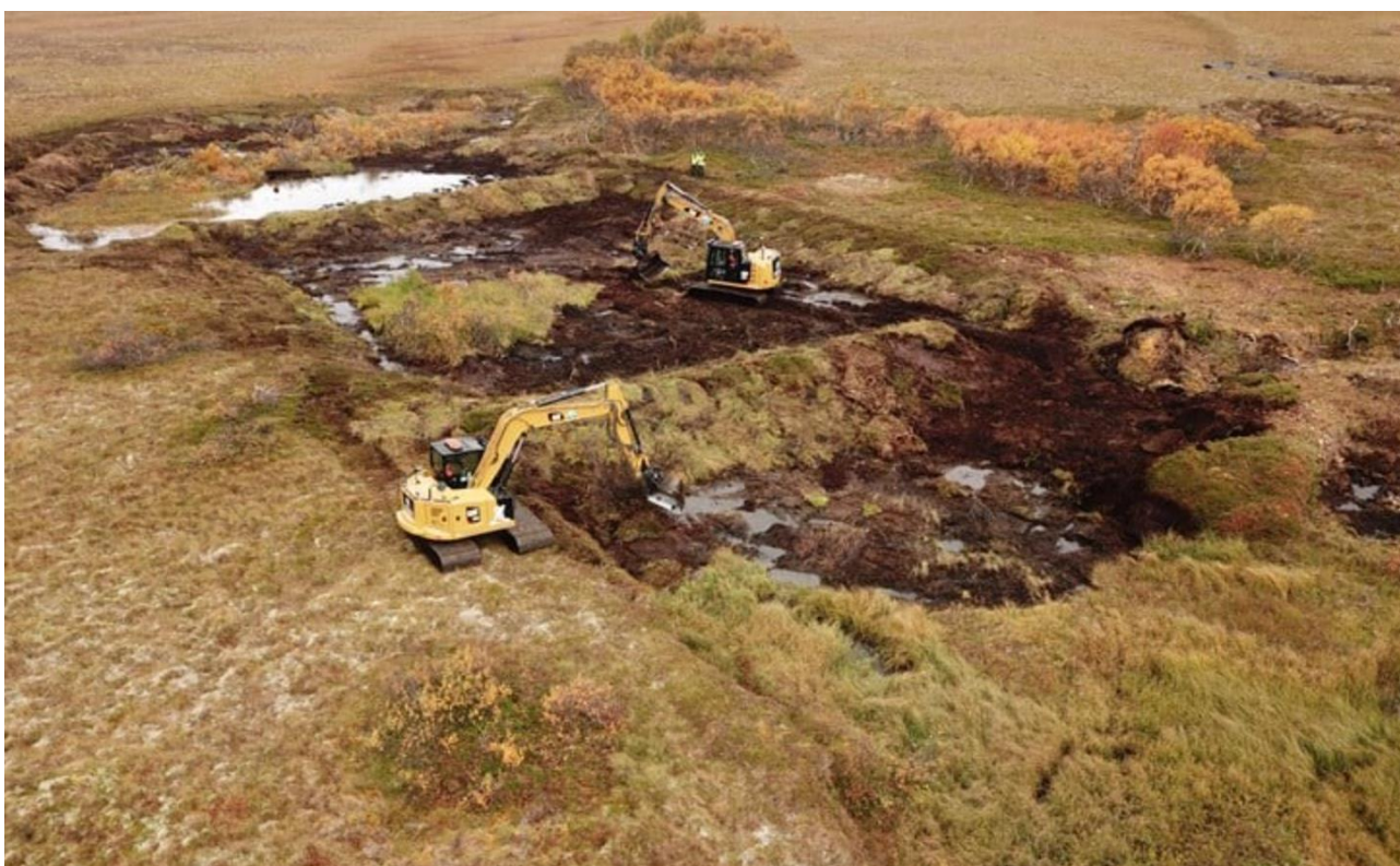
Figur 13: Restaurering av myr ved å tette gamle grøfter kan skape betre leveområde for ei lang rekke artar, og samtidig lagre meir karbon og dempe flaumar. Foto: Statsforvaltaren.
