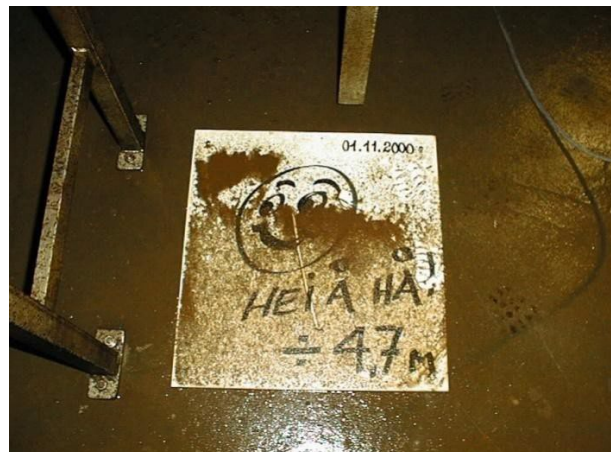
Jamoksiderande bakteriar i råvatnet som førte til avleiringar på trykksilar og i reintvassbasseng i Gamleidet VB1
