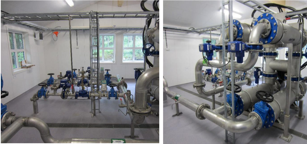
Maskin- og prosessrom Garsholhaugen VB2 (utgående ledninger til venstre - UV-anlegget til høyre)
