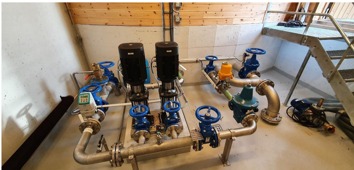
Eiksund høgdebasseng (gravitasjon innløp - pumping utløp)
