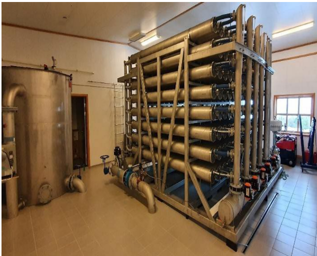
Prosessrom-membranfilteranlegget/nanofiltrering
