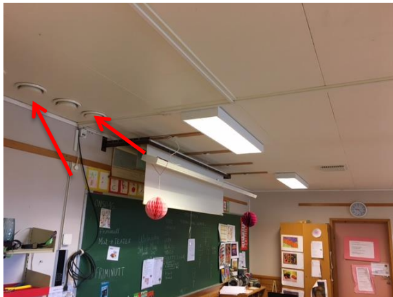
Bilde nr. 8. Avtrekket/utluften er markert med røde piler.
